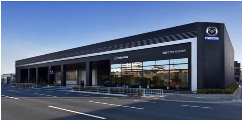
PHOTO: 2016年12月竣工 新金岡店
