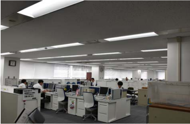
○本社4階事務所LED化状況
